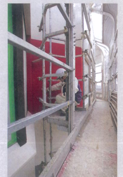
仕上げ材塗布。手前に見えるサッシの縦枠にもEPSを張って断熱性を高めるようにした
