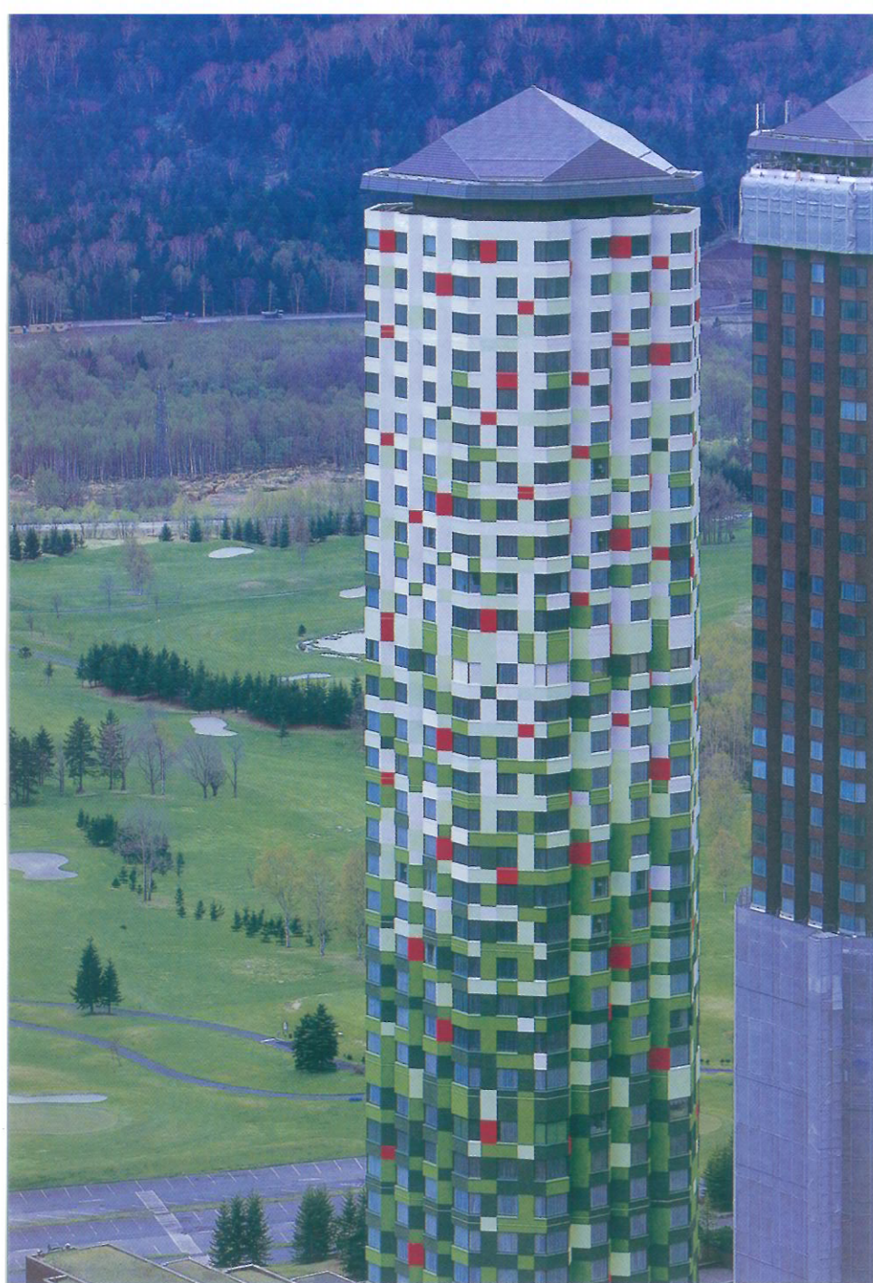
パネル単位で色を変えた外壁。後でパネル1枚を取り替える必要が生じた際、色合わせはむしろ容易だ
